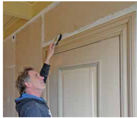
Vorbereidende werkzaamheden voor het gespannen behang.
