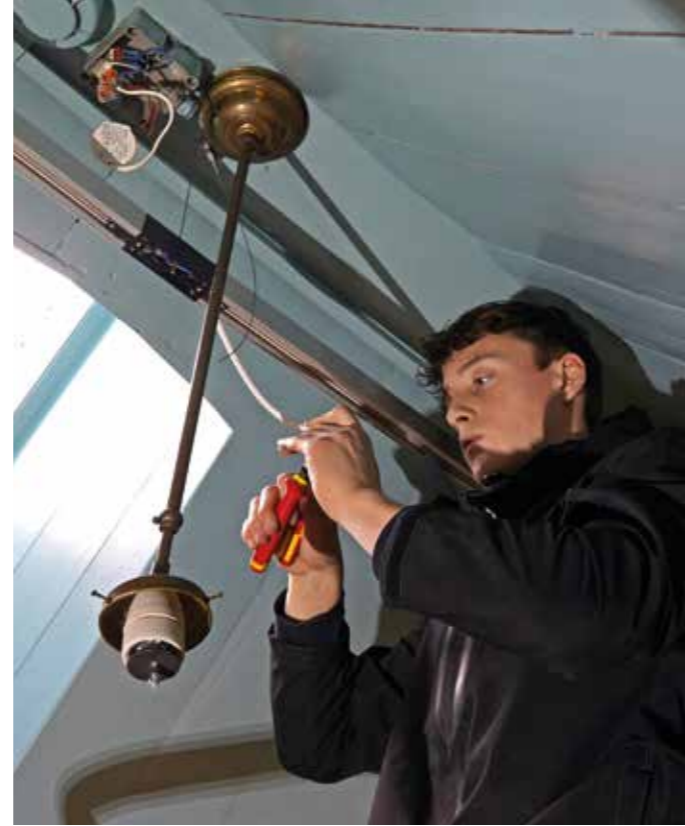
Overal in het huis werd de verlichting vervangen, zoals hier op de zolderetage.
